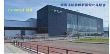
北海道新幹線新函館北斗駅舎 2016年3月 開業
