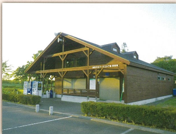
中央PG場 管理棟
